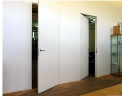
im geschlossenen Zustand sind die Türen eine Fläche mit der Wand.
